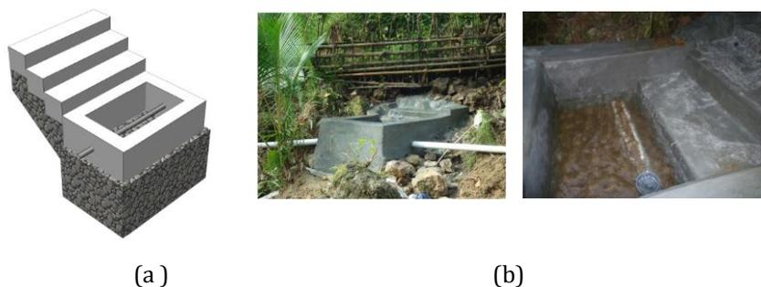
**Gambar 5** Desain 3 dimensi (a) dan kondisi lapang (b) bak penampung air untuk menampung air dari mata air dan dam parit I di DAS mikro Makarua Desa Limampocoe, Kecamatan Cenranae, Kabupaten Maros
