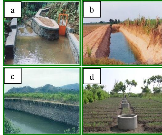
**Gambar 1** Beberapa prototipe teknologi panen hujan dan aliran permukaan: dam parit (a), lebung (b), embung (c), dan sumur renteng (d)
